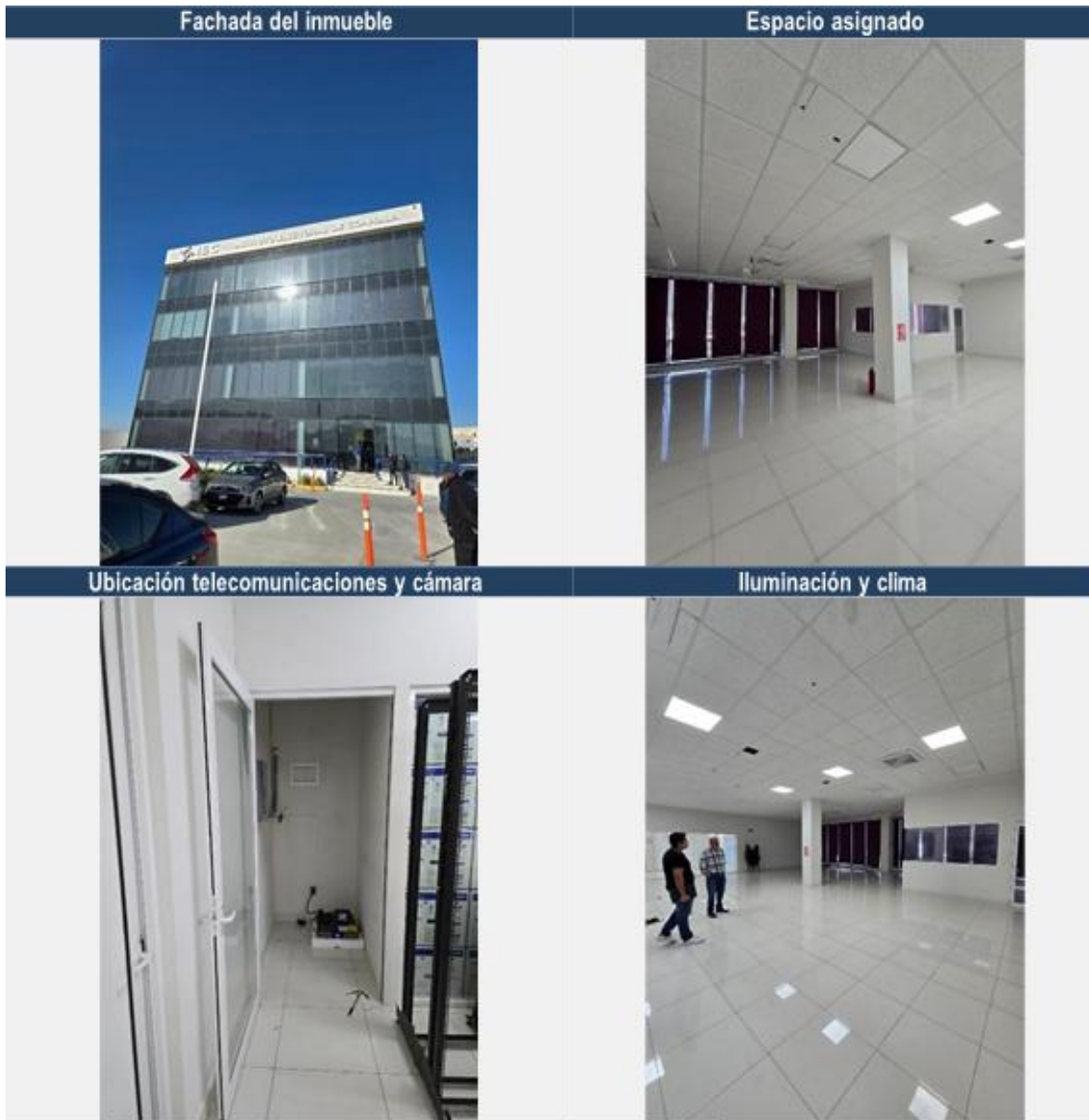
Imagen 4. Inspección de CCV Principal
